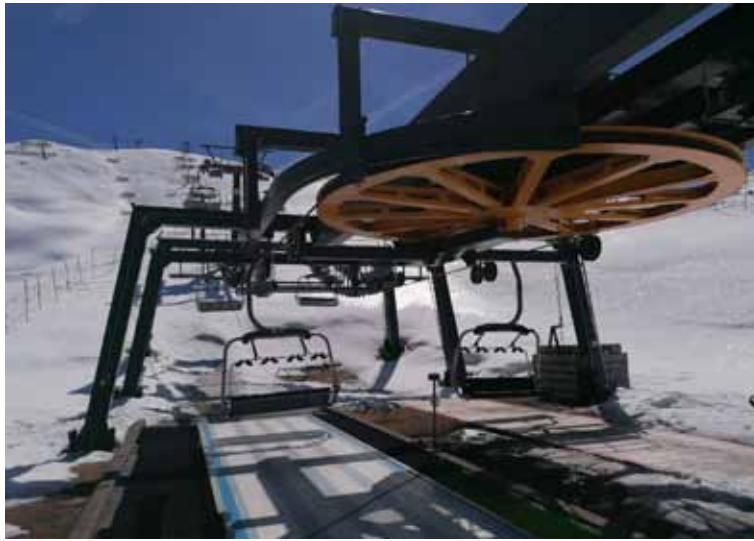
Stazione di rinvio di un impianto ad ammassamento permanente
