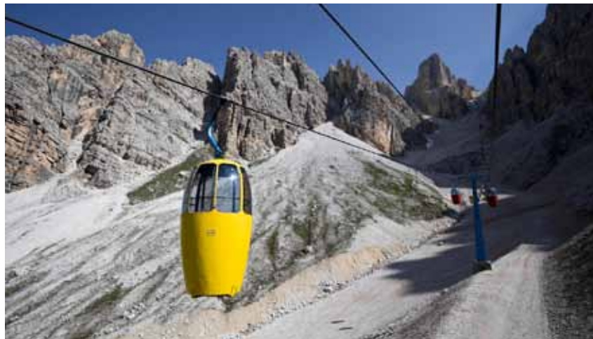
Cabinovia ad ammassamento fisso
