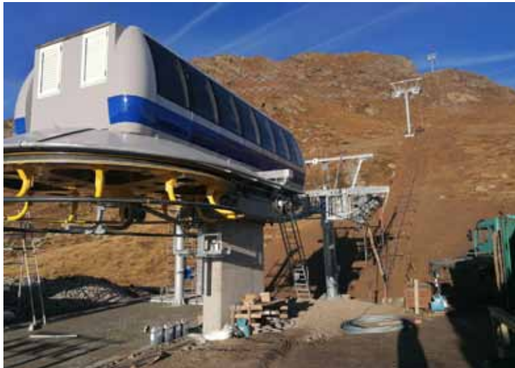
Stazione motrice di una seggiovia ad ammortamento fisso
