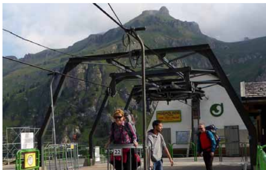
Cestovia ad ammassamento fisso
