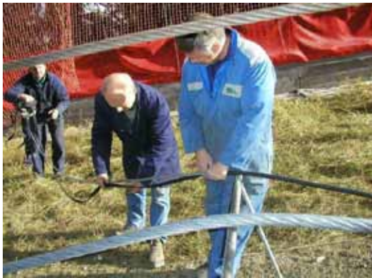
Rivestimento del codino raddrizzato
