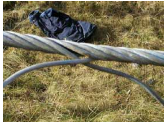
Fase di accostamento dei trefoli sul nodo
