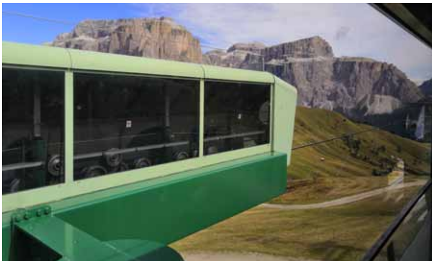
Dettaglio della copertura dei meccanismi del giostazione
