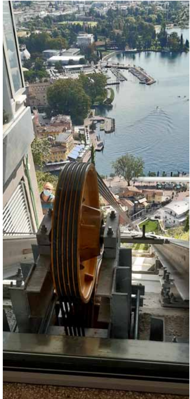
Dettaglio ascensore inclinato
