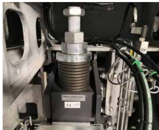
Dettaglio del freno di emergenza di impianto D-line
