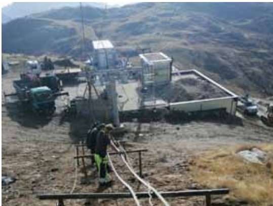
Zona di lavoro con fune stesa per l'impalmatura
