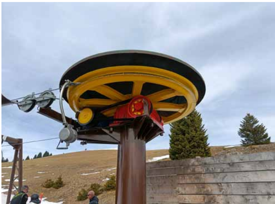
Argano motore di sciovia
